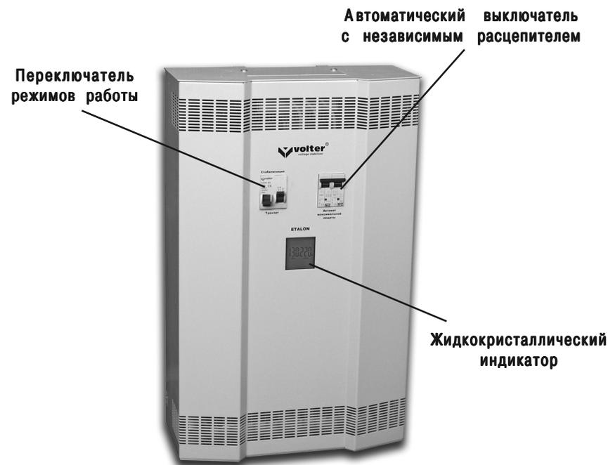
Рис. 1. Стабилизатор напряжения
